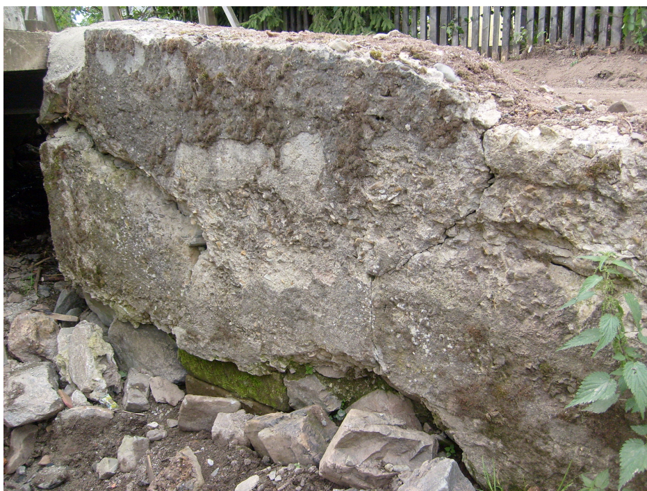
Fot.5 Widok spękanych i podmytych skrzydełek od strony dolnej wody.
