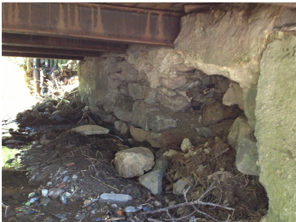
Fot.4 Widoczne braki kamienia na przyczółkach.
