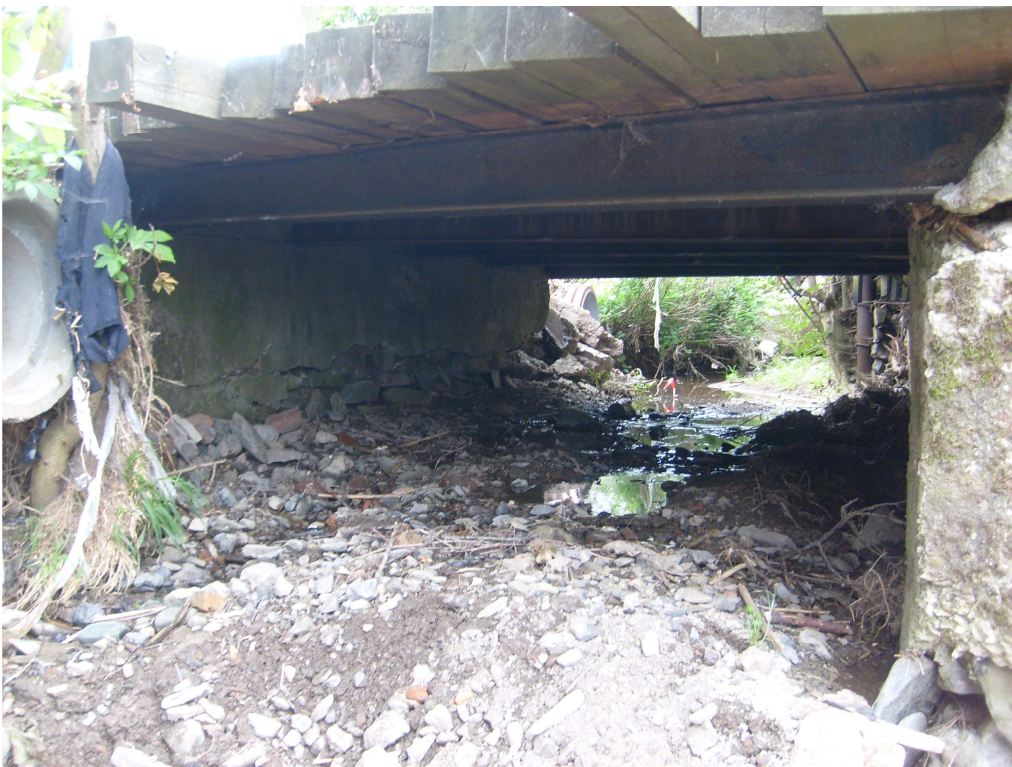
Fot.3 Widok konstrukcji mostu od strony dolnej wody. Podmyte i widoczne braki kamienia na przyczółku.
