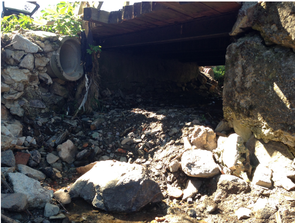
Fot.2 Widok mostu od strony dolnej wody. Zamulone dno naniesionymi kamieniami i żwirem zmieszanim z ziemią, naniesioną przez wodę podczas powodzi.
