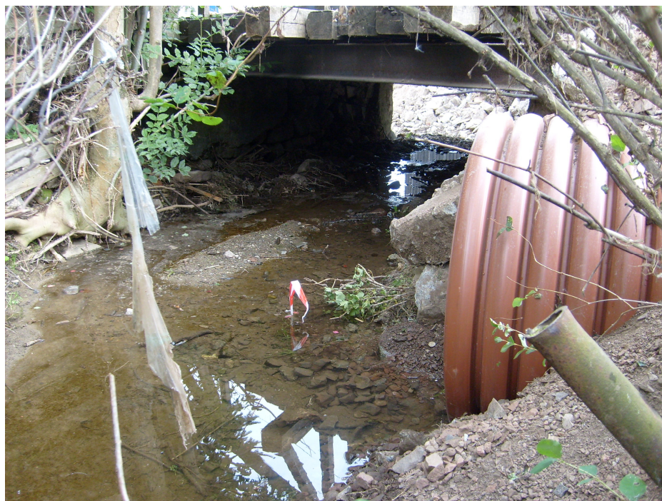
Fot.6 Widok wymienionego przepustu PPØ800 od strony górnej wody.
